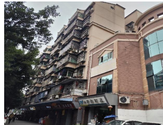
可比实例 A 建筑物外观
